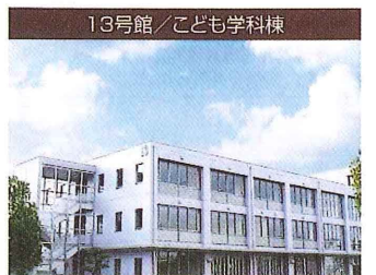
13号館/こども学科棟
